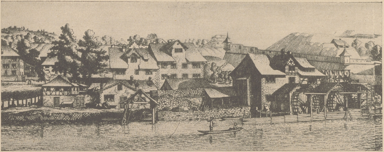
Das Geburtshaus Conrad Ferdinand Meyers in Zürich; das Doppelwohnhaus in der Mitte des Bildes. Rechts die Limmatburg, davor die „Walche“, links davon die Färberei, „die Färb“.
