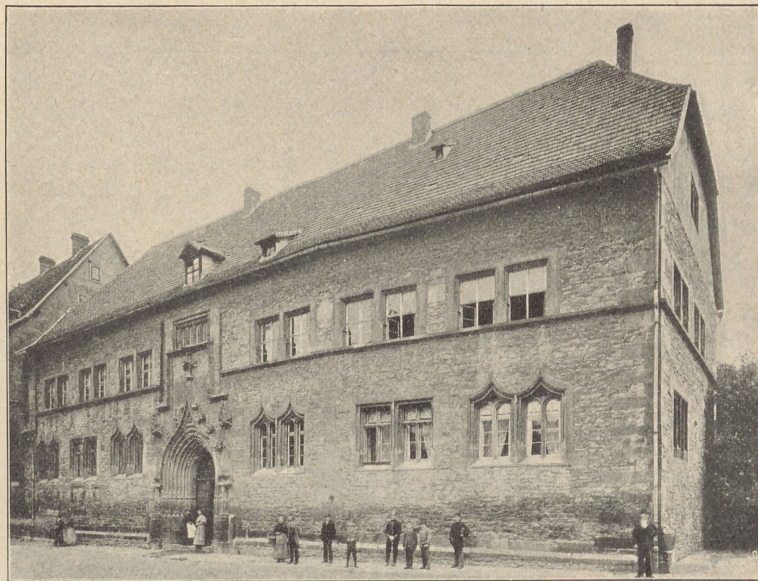
Das ehemalige Universitätsgebäude in Erfurt.
