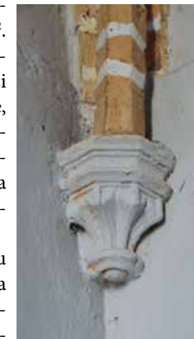
Fot. 8. Kościół Podwyższenia Krzyża Świętego w Przezmarku, wspornik sklepienia przedsionka, fot. autor
