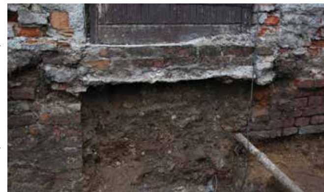
Ilustracja 12. Zamurowanie przestrzeni pomiędzy północną i południową częścią obecnego budynku Gimnazjum. Źródło: Archiwum MAH, fot. P. Wlizio.
