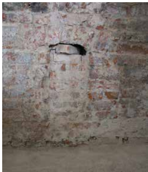
Ilustracja 11. Zamurowane okno średniowiecznej klatki schodowej w budynku Gimnazjum. Źródło: Archiwum MAH, fot. P. Wlizio.
