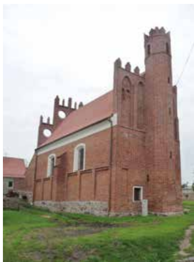
Fot. 5. Kaplica Najświętszej Marii Panny w Prabutach, elewacja zachodnia, fot. autor
