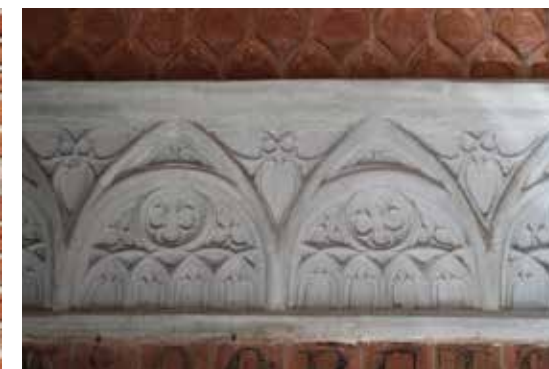
Fot. 7. Katedra Fromborska, maswerki w kruchcie zachodniej, fot. autor
