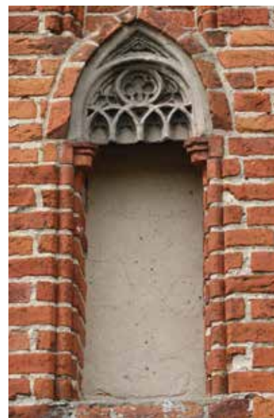
Fot. 6. Kościół Podwyższenia Krzyża Świętego w Przezmarku, fragment maswerku blendowego, fot. autor
