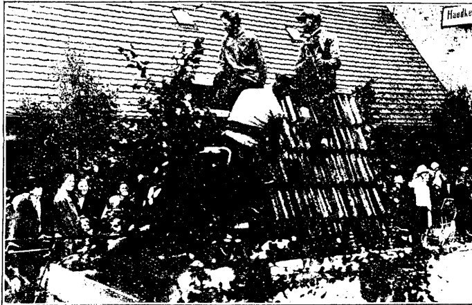
Wagen der Dachdecker
