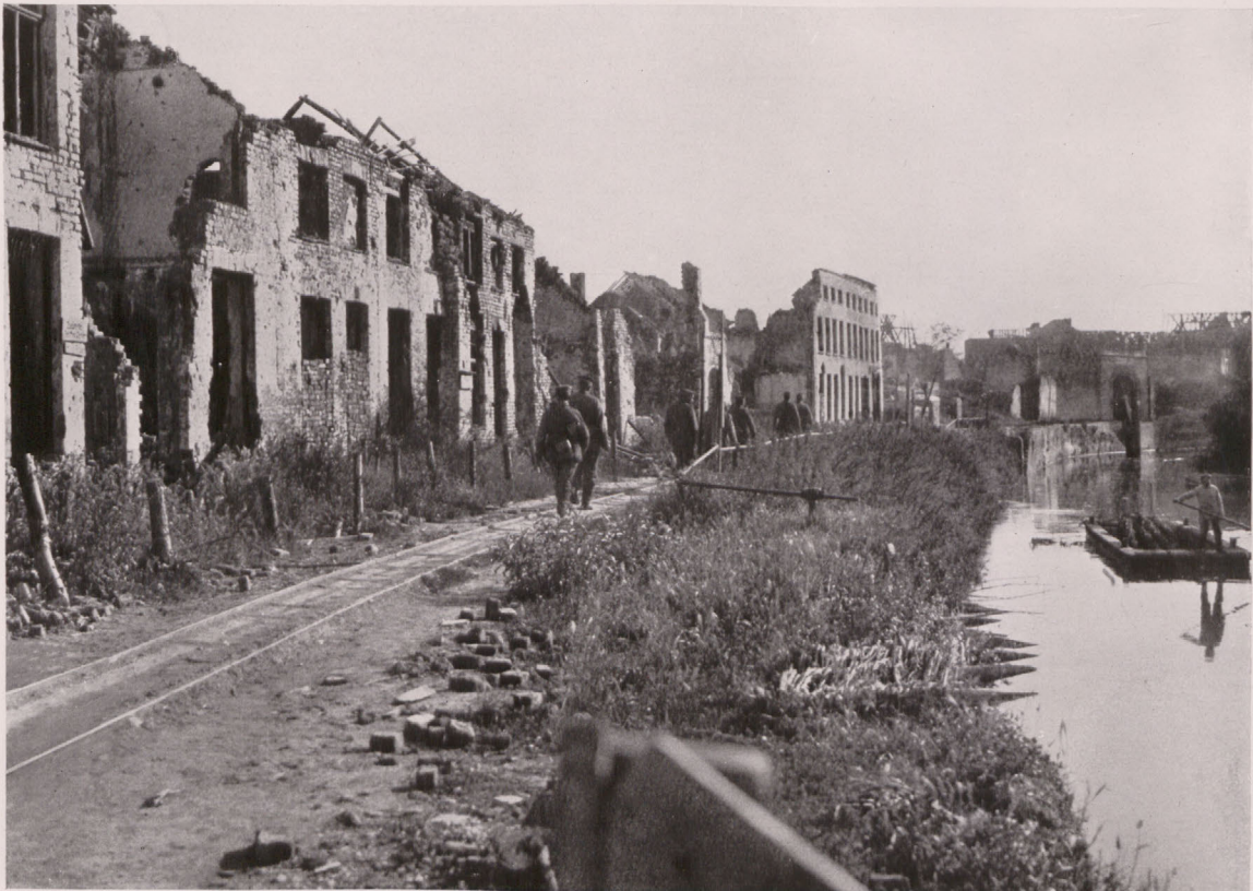
Straße am Kanal in Dirmuiden. — Aufnahme von 1916.
