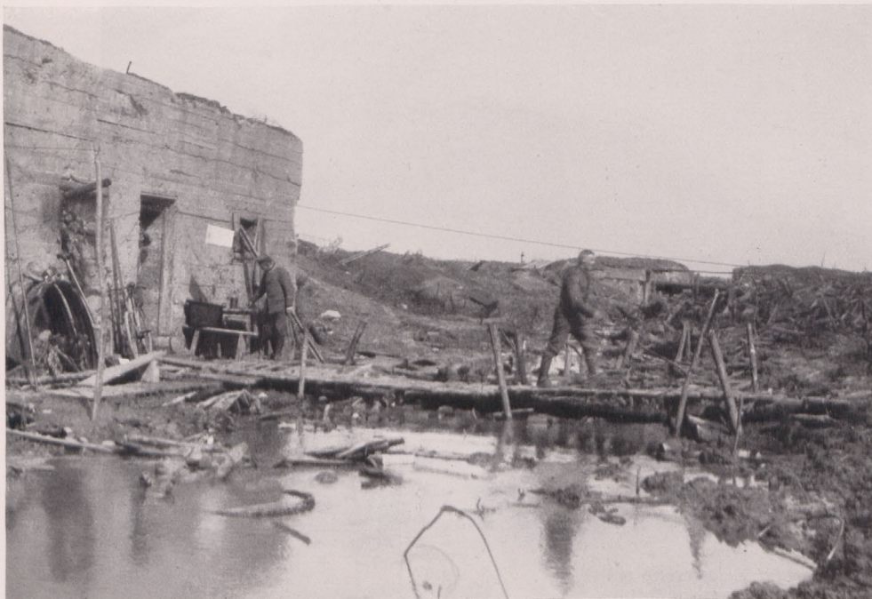
Betonunterstand in Gegend Hollebeke. Da die Anlage von Unterständen in dem verfumpften flandrischen Boden je länger je mehr unmöglich wurde, war man gezwungen, auf dem gewachsenen Boden mächtige Betonklötze (Bunker) zu errichten.
