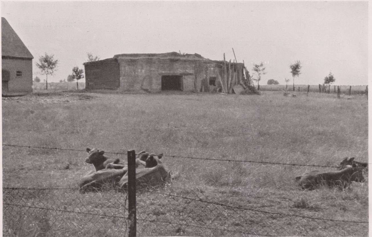
Deutsche Betonunterstände bei Langemarck, die alle Stürme der Materialschlachten überdauert haben, dienten nach dem Kriege den Bauern als Geräteschuppen.
