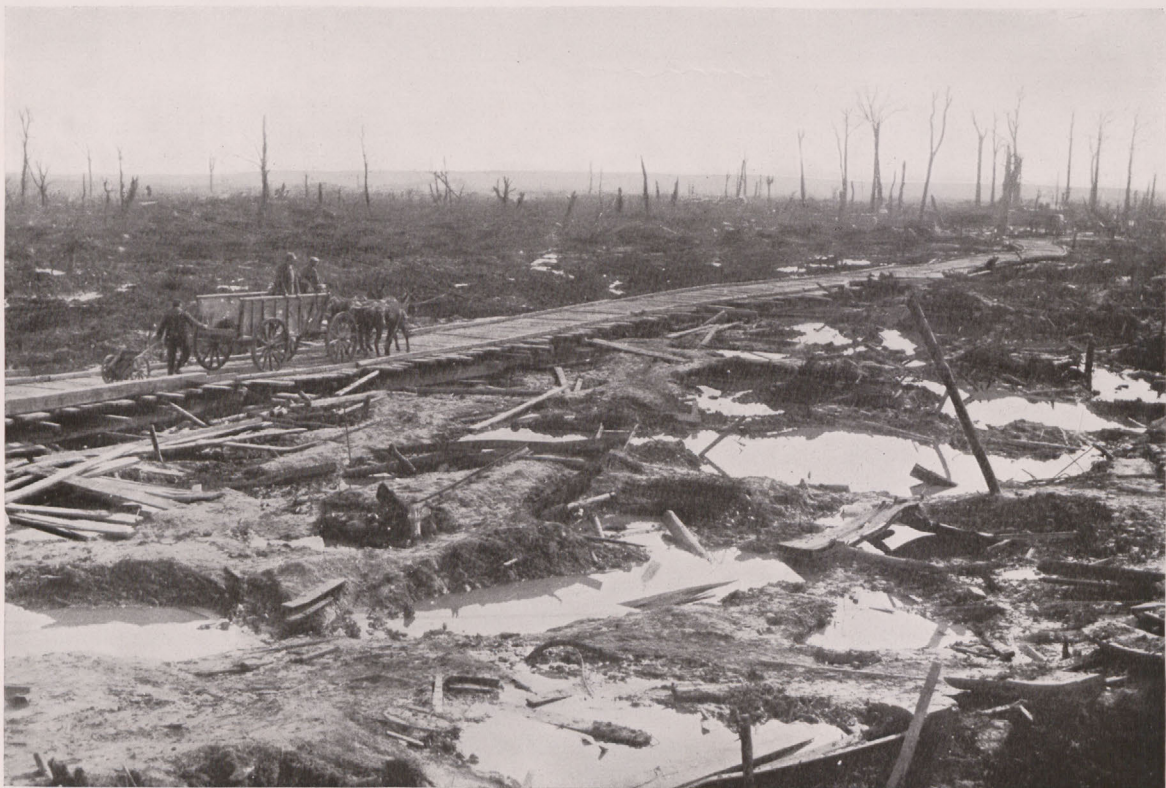
Außerhalb der Bohlenwege war in dem Trichterfeld ein Verkehr von Fahrzeugen vielfach gar nicht mehr möglich.
