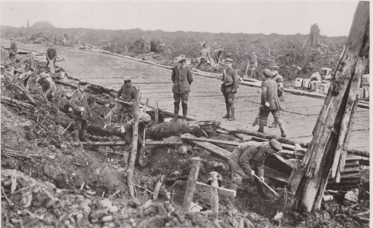
Meilenlange Bohlenstraßen wurden gebaut, um der Kampffront Verpflegung und Kampfgerät zuführen zu können. So entstand ein ganz neues Wegenetz, eine Glanzleistung deutscher Pioniere.
