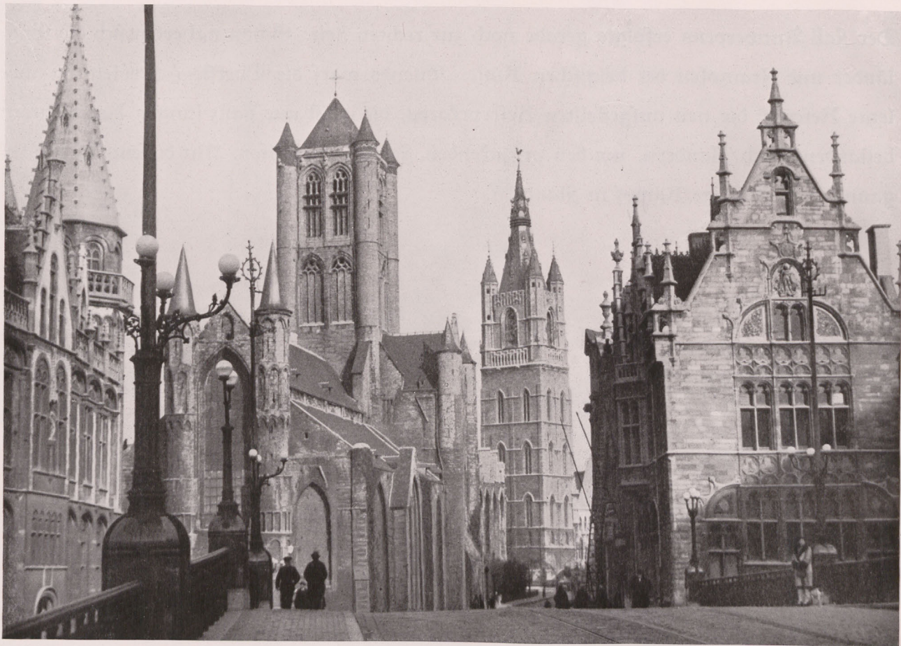
Gent. Blick von der St.-Michaels-Brücke auf die St.-Nikolaus-Kirche und den Belfried.
