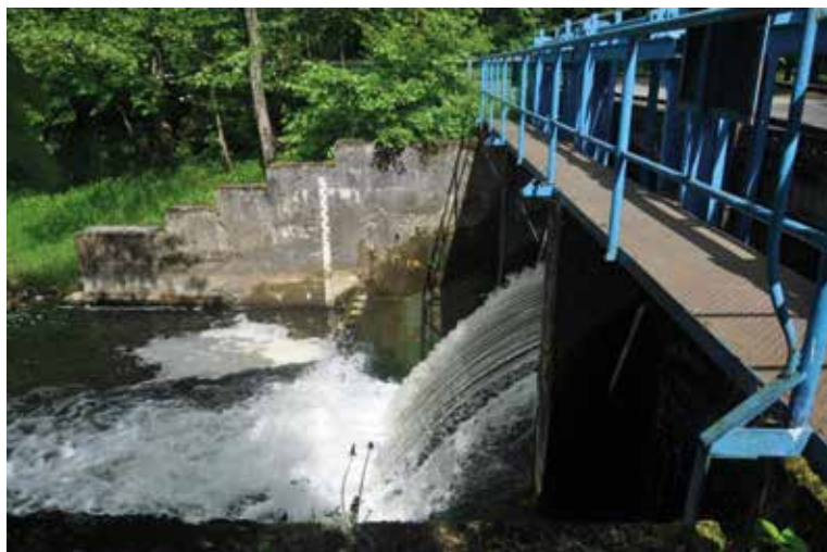
Ryc. 4. Jazomost regulujący ilość wody wpływającej do kanału ulgi w Słupskim Młynie. Fot. W. Kulczykowski.
