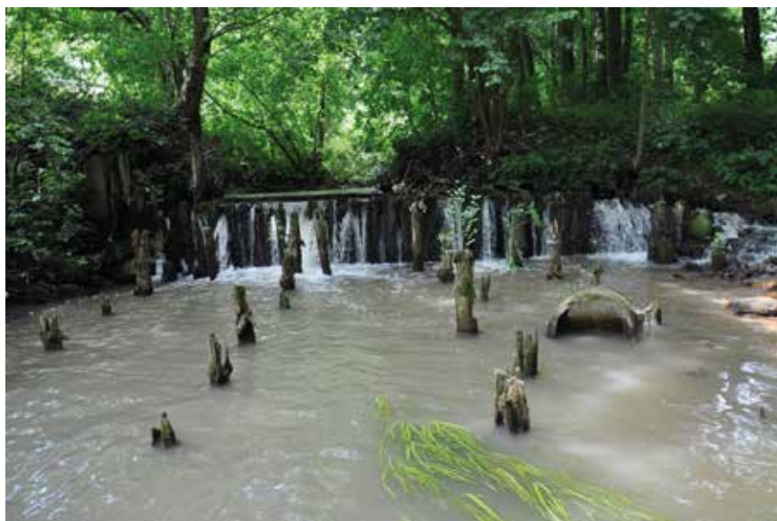
Ryc. 8. Drewniana konstrukcja w Rogóźnie-Zamku w rzece Gardęga. Fot. W. Kulczykowski.
