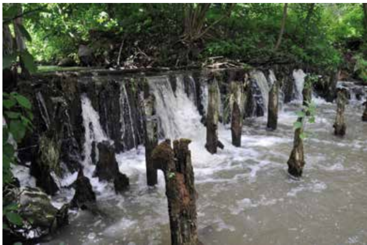
Ryc. 9. Drewniana konstrukcja w Rogóżnie-Zamku w rzece Gardęga. Fot. W. Kulczykowski.
