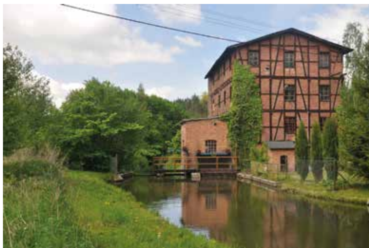
Ryc. 2. Dziewiętnastowieczny budynek młyna w Słupskim Młynie. Obecnie prywatna elektrownia wodna i skansen. Fot. W. Kulczykowski.
