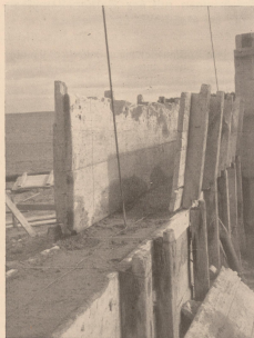
Im Bau begriffene Kalksandstampermauer.
