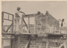
Vermauerung der Fensterzargen.
