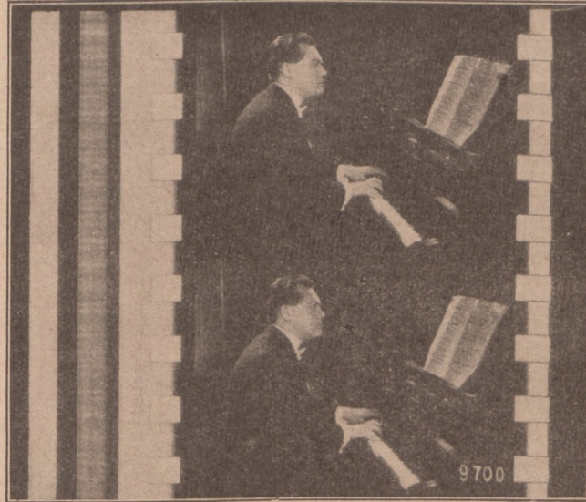
Abb. 17. Stück aus einem Tri-Ergon-Tonfilm. Der eigentliche Klangfilm ist noch an der Seite, außerhalb der Perforation, aufkopiert.
