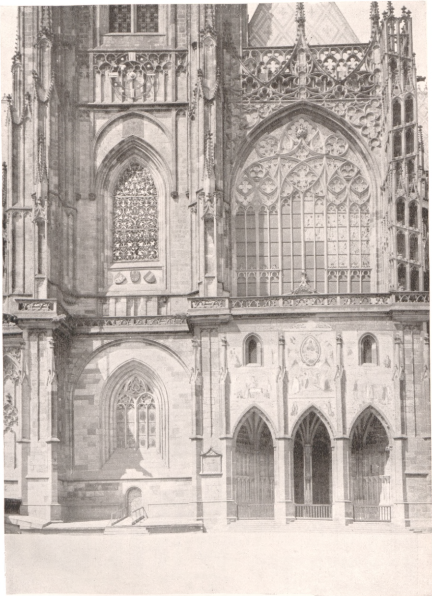
Taf. III: Südquerhaus und Turm des Veitsdoms (Die Maßwerke des Querhausfensters und des Turmerdgeschosses sind neu)
