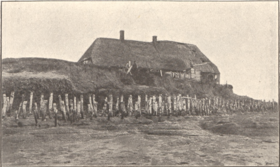
Abb. 2. Halbzerstörte Werft (im Vordergrund Notschutzbauten).
