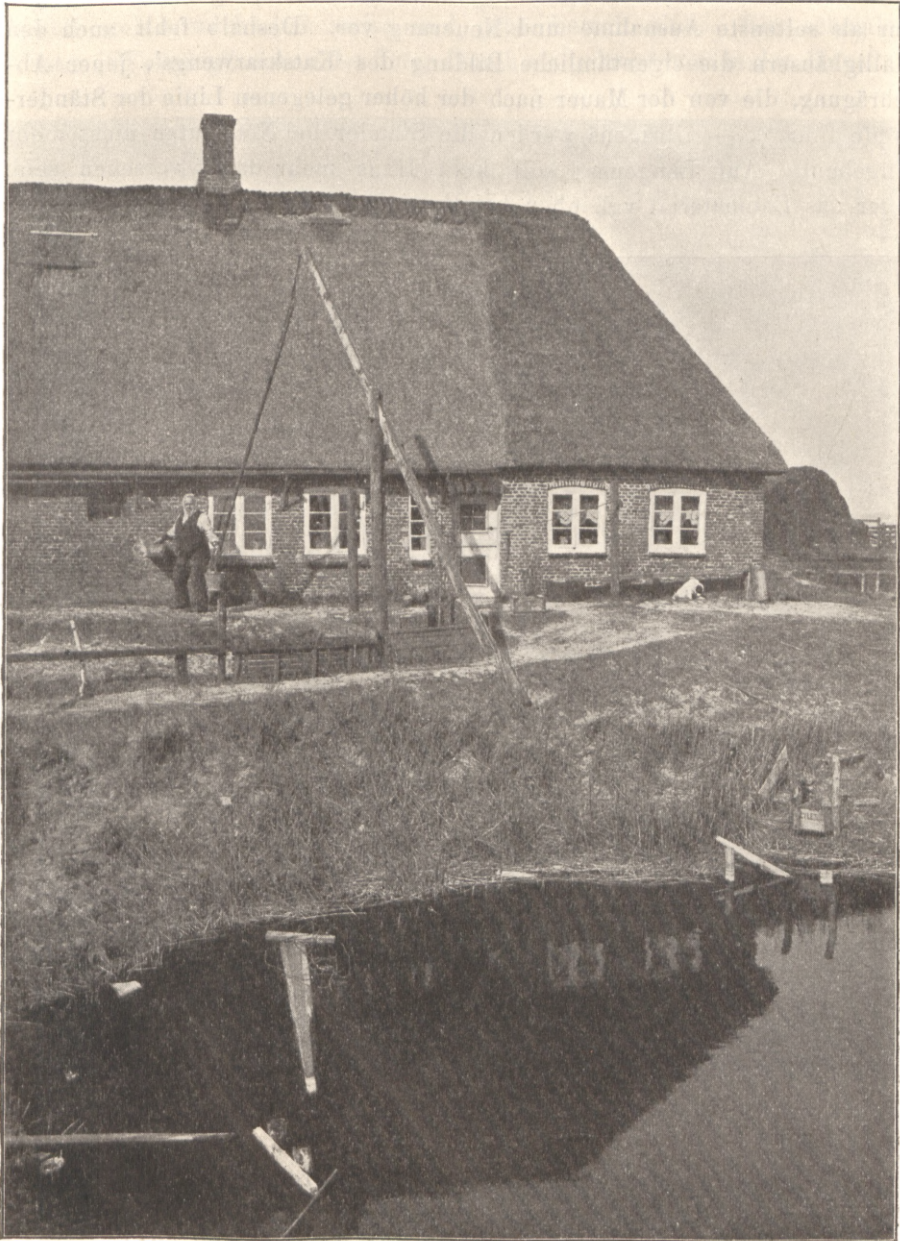
Abb. 8. Pumpe, Feeding, Eingang am Haus.
