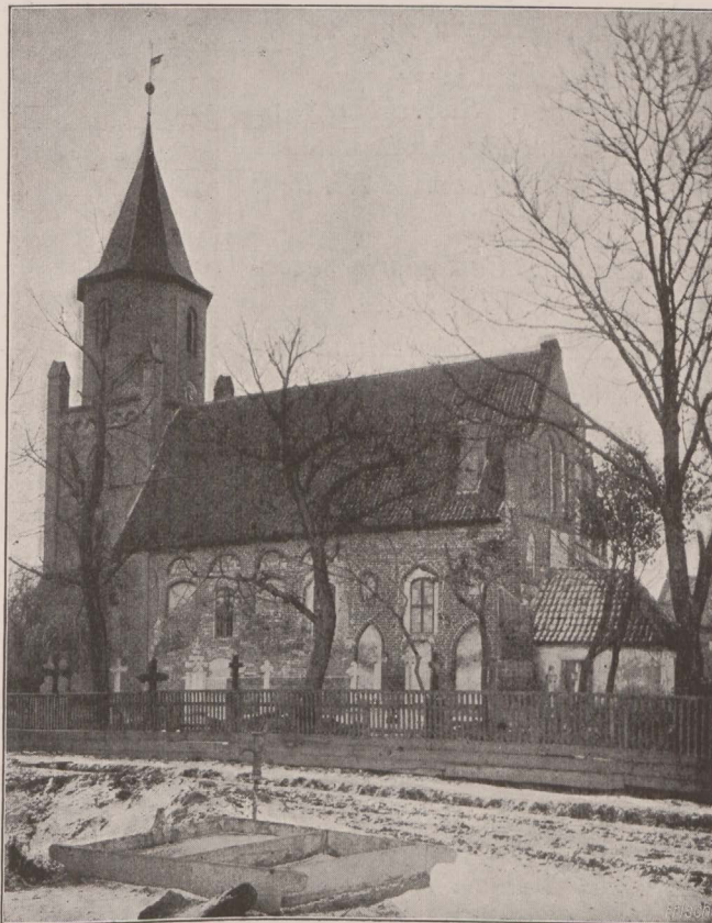
Abb. 84. Südostansicht der evang. Pfarrkirche in Gnojau.
