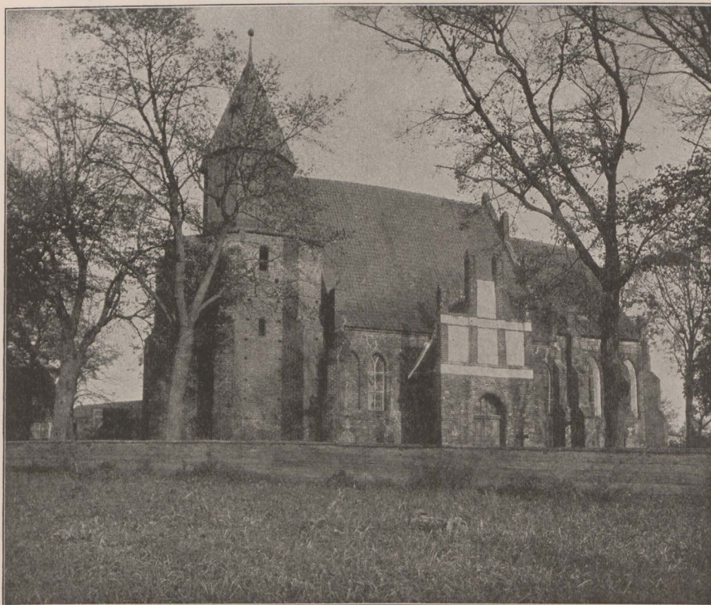
Abb. 417. Südseite der katholischen Kirche zu Tiege
