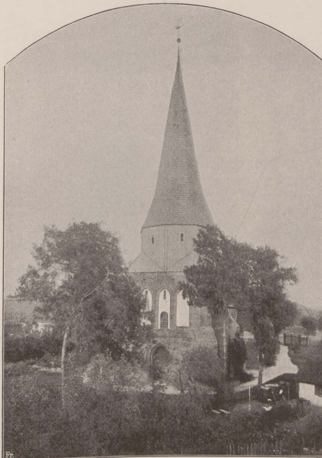
Abb. 245. Westseite der katholischen Pfarrkirche zu Groß-Montau.
