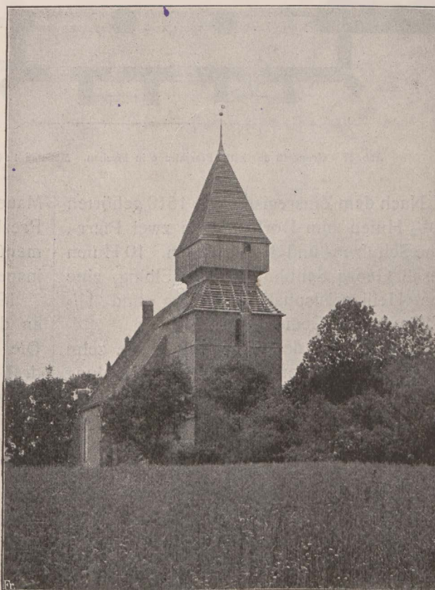
Abb. 56. Kath. Pfarrkirche in Fischau. Ansicht von Nordwesten (1915).
