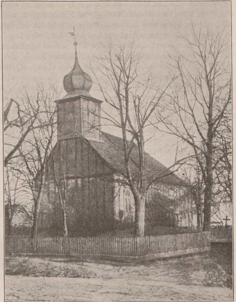
Abb. 3. Ansicht der Kirche zu Gr. Albrechtan.
