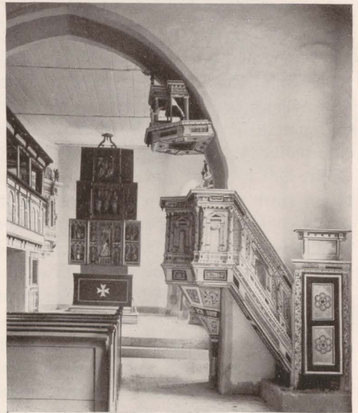
26. Welfersdorf (Schlesien), jetzt katholische Kirche
