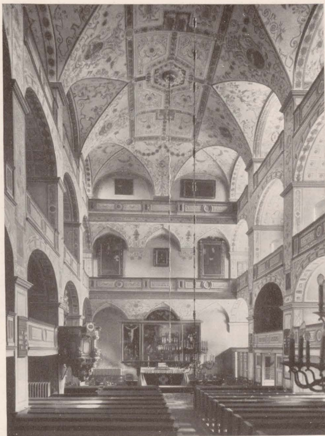
20. Stettin, Schloßkirche, Zustand nach der Renovierung
