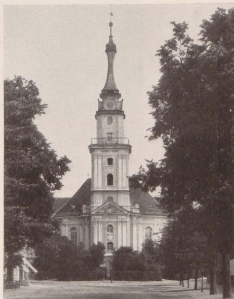
84. Carlsruhe (Oberschl.), Ev. Pfarrkirche
