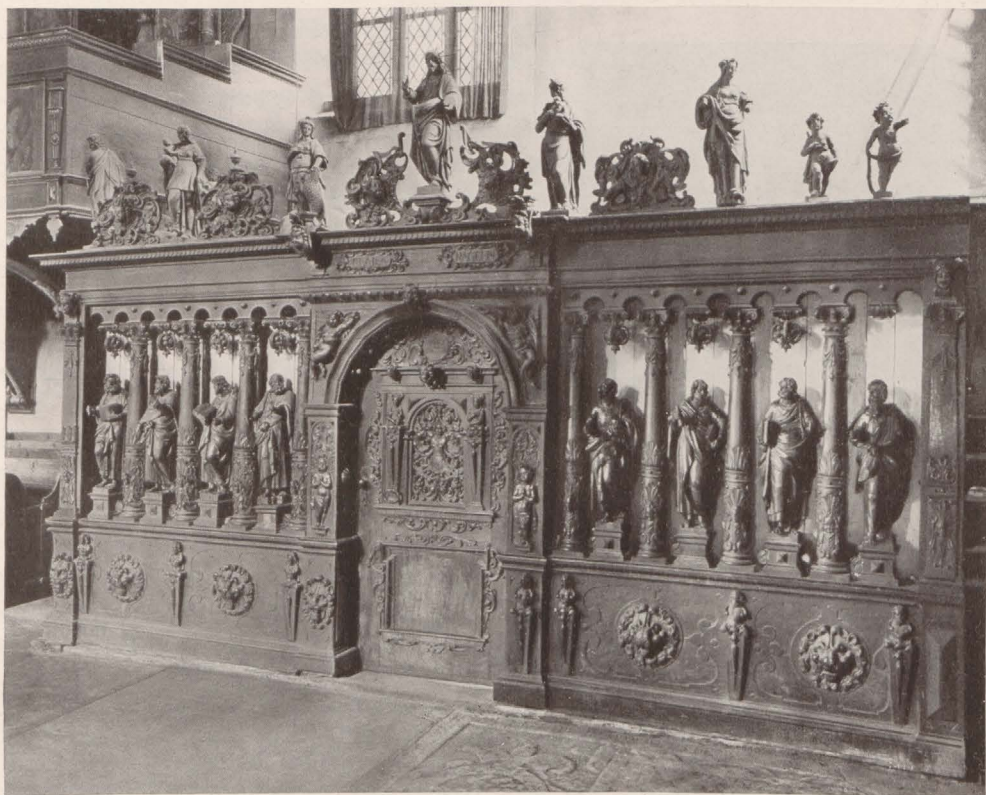
181. Insterburg (Ostpreußen), Evangelische Pfarrkirche, Eingang zur Taufkapelle
