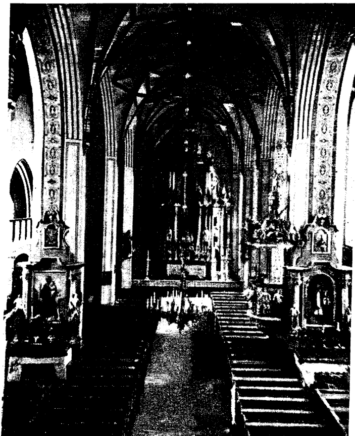
Abb. 23. Pfarrkirche zu Seeburg, Mittelschiff n. Osten.
