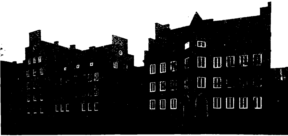
Städtische Wohnhausgruppe mit Zugang zum neuen Sportplatz in der Sodekerstraße.
