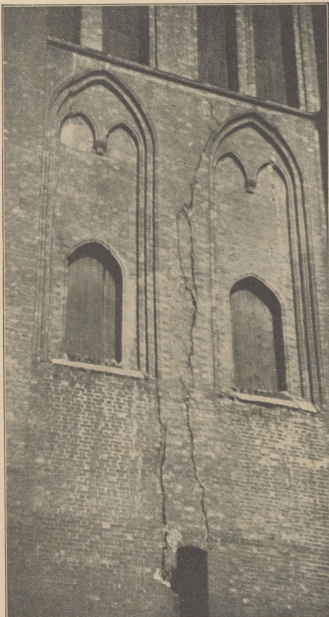
Risse im Mauerwerk der Marienkirche. (Transeur. Preß.)
