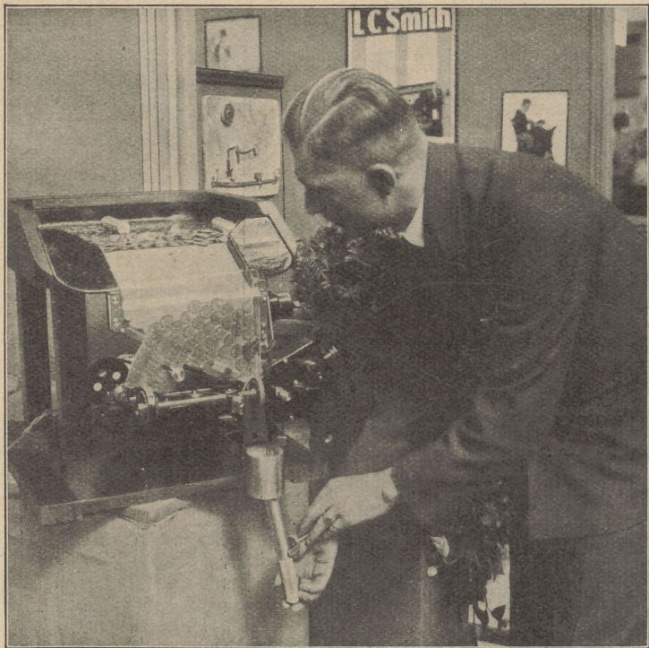
Die Geld-Zählmaschine sortiert, zählt und rollt die Münzen selbsttätig. (R. Sennede.)
