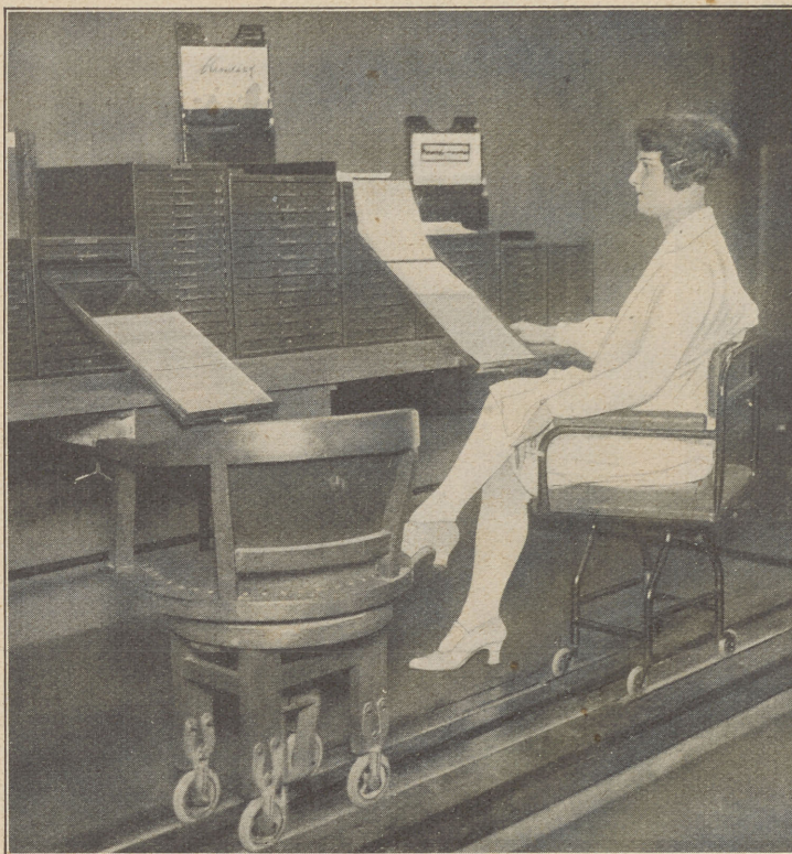
Der rollende Bürostuhl zur Erleichterung und Beschleunigung von Arbeiten an der Kartothek. (S. Basch.)
