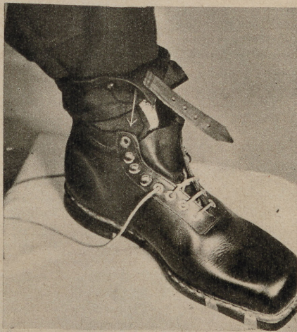
Die neue Schneedichtung an der Schihose. Nahtloser Schiestiefel mit dreifach durchgehender Sohle
