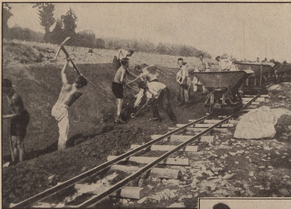
Arbeit am Einschnitt der neuen Straße ohne Verwendung erleichternder Maschinen
