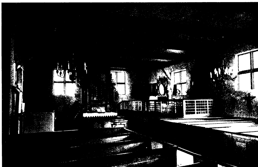
58 u. 59. Dobberphul Kr. Hammin. Äußeres vor, Inneres nach der Wiederherstellung.
