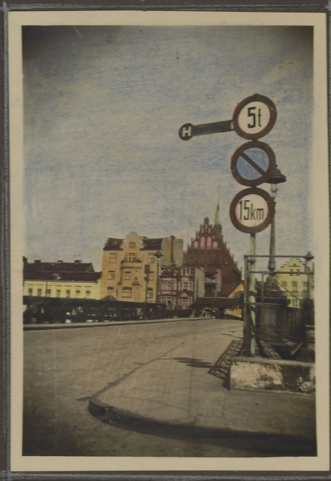
Leegebrücke mit St. Marien- Kirche
