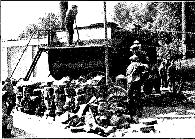
An der Asphaltlochmaschine
