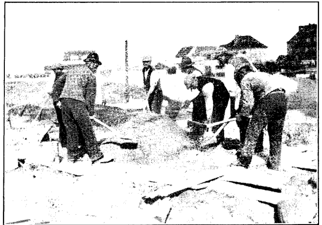
Auf dem Bauplatz
