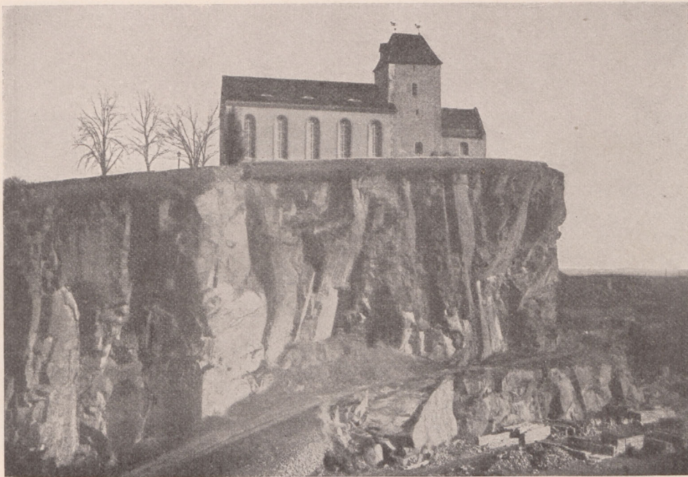
105. Halb abgebaute Granitporphyrkuppe bei Beucha i. S. Phot. von J. Mühler in Leipzig.
