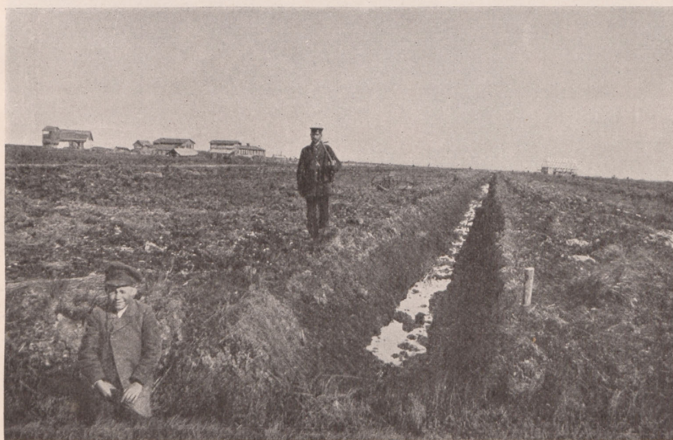
70. Trockenlegungsarbeiten im Augtumaler Moosbruch im Memeldelta. Nach Photographie.
