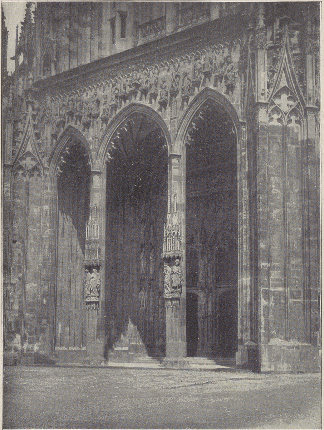
Eingangsbogen des Ulmer Münsters.
