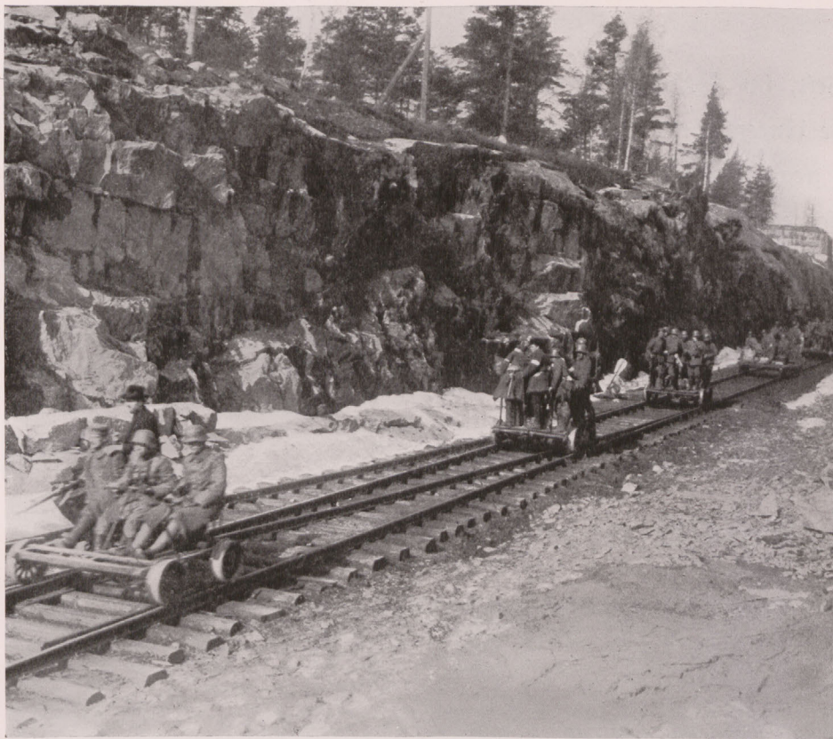
Beschleunigung des Vormarsches durch Benutzung von Drahsinen.
