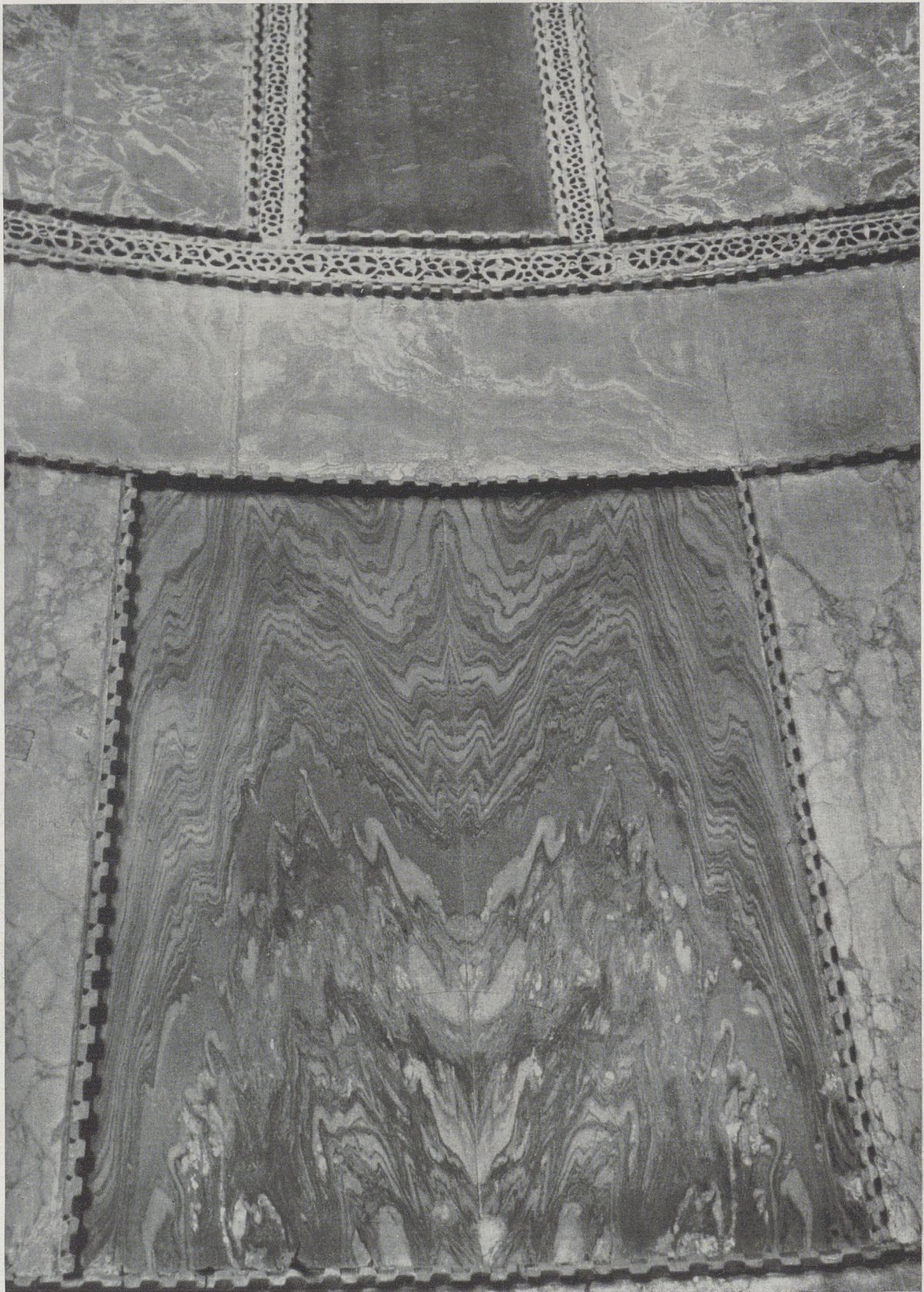
Abb. 58. Marmorverkleidung der Südostkonchenwand
