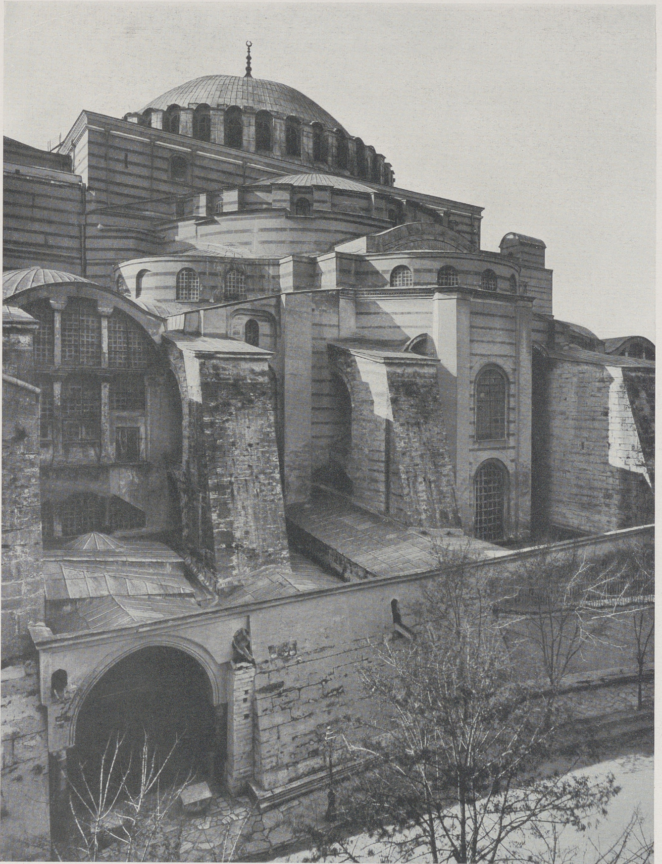
Abb. 9. Ansicht von Osten
