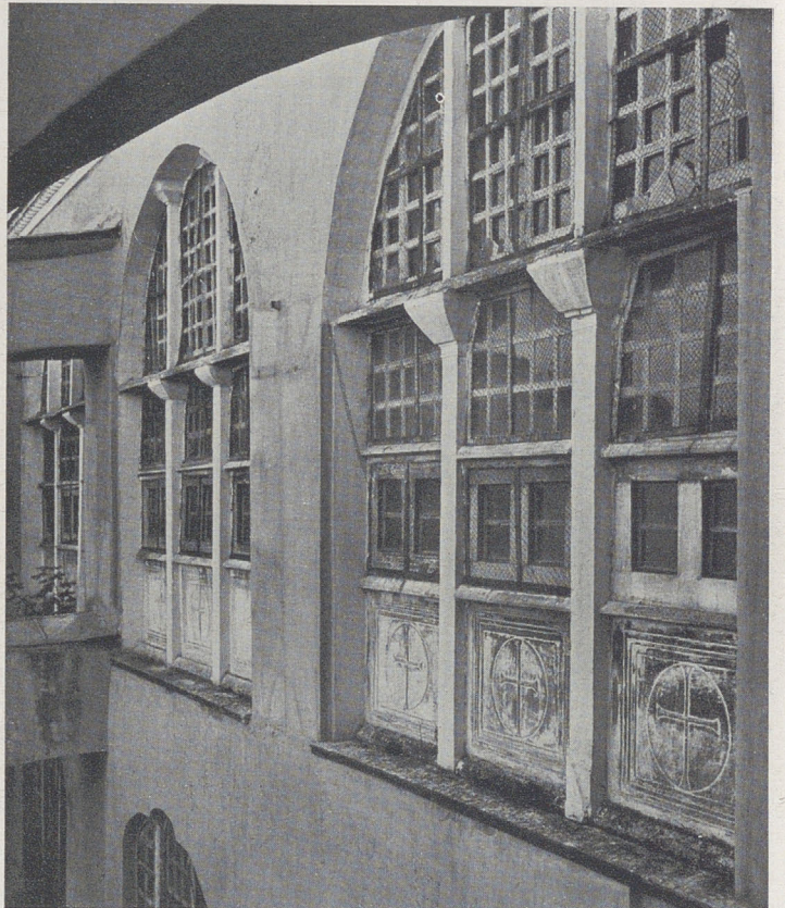
Abb. 41. Fenster der Galeriewestseite
