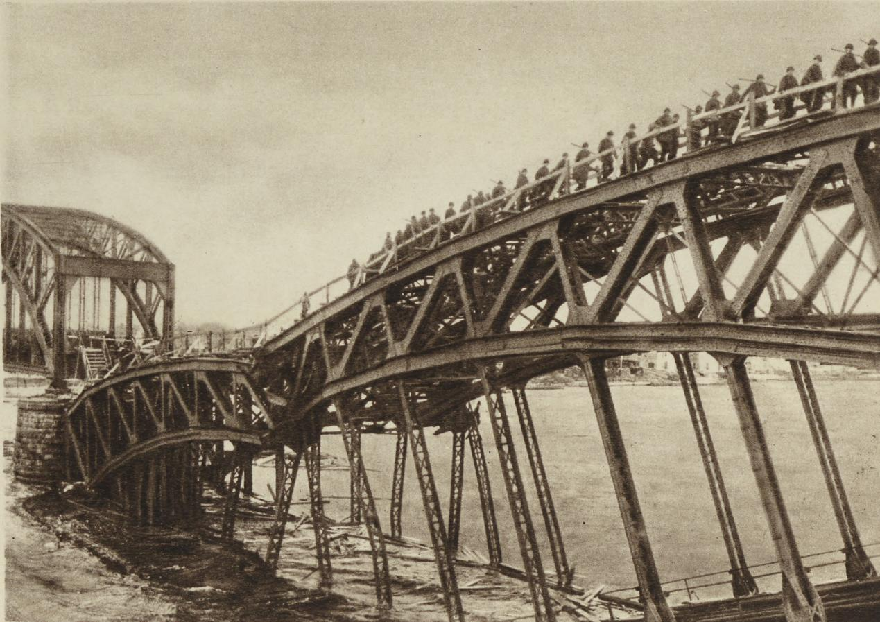
Die von den Russen am 3. September 1917 gesprengte Eisenbahnbrücke über die Düna bei Riga. Deutsche Pioniere der 8. Armee haben einen behelfsmäßigen Übergang für die Infanterie gebaut. Die Breite des Flusses beträgt an dieser Stelle ungefähr 250 m.
