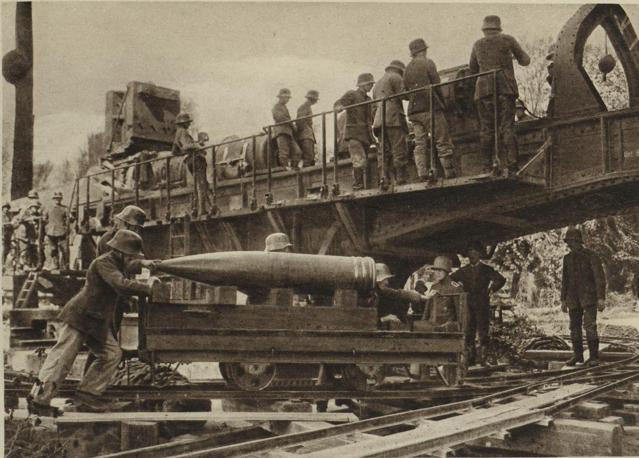
Das 38 cm Geschütz wird geladen. Die Munition muß wegen ihrer Schwere (18 Tr.) auf besonderen Wagen herangesfahren werden. Die Aufstellung dieser schweren Geschütze beanspruchte vielfach eine mehrwöchige Vorbereitung durch Betonierungsarbeiten, Anlegen von Schienensträngen für Munitionsnachschub usw. Rechts oben im Bild ein Kran, mit Hilfe dessen die Granaten emporgezogen werden.
