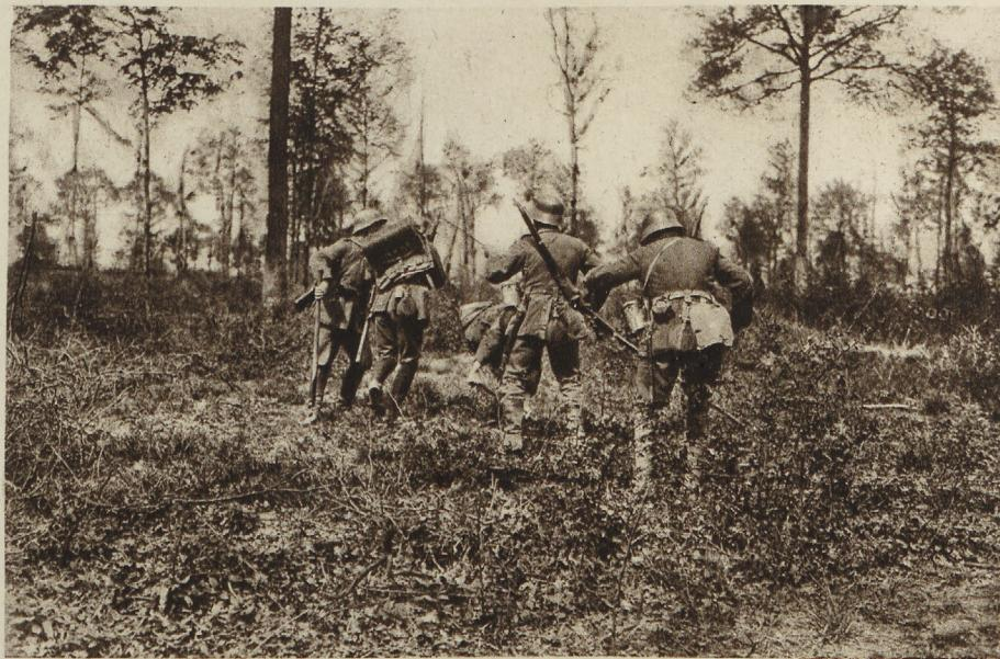
Legen von Telefonleitungen am Kemmel. Der Infanterist trug den Armeefernsprecher vor der Brust, das Leitungsmaterial in einem besonderen Tornister (2 mal 500 m auf 2 flachen Trommeln). Zum Hochlegen einer Leitung diente eine Drahtgabel, in kürzere Stangen- teile zerlegt, senkrecht an der Seite des Tornisters getragen.
