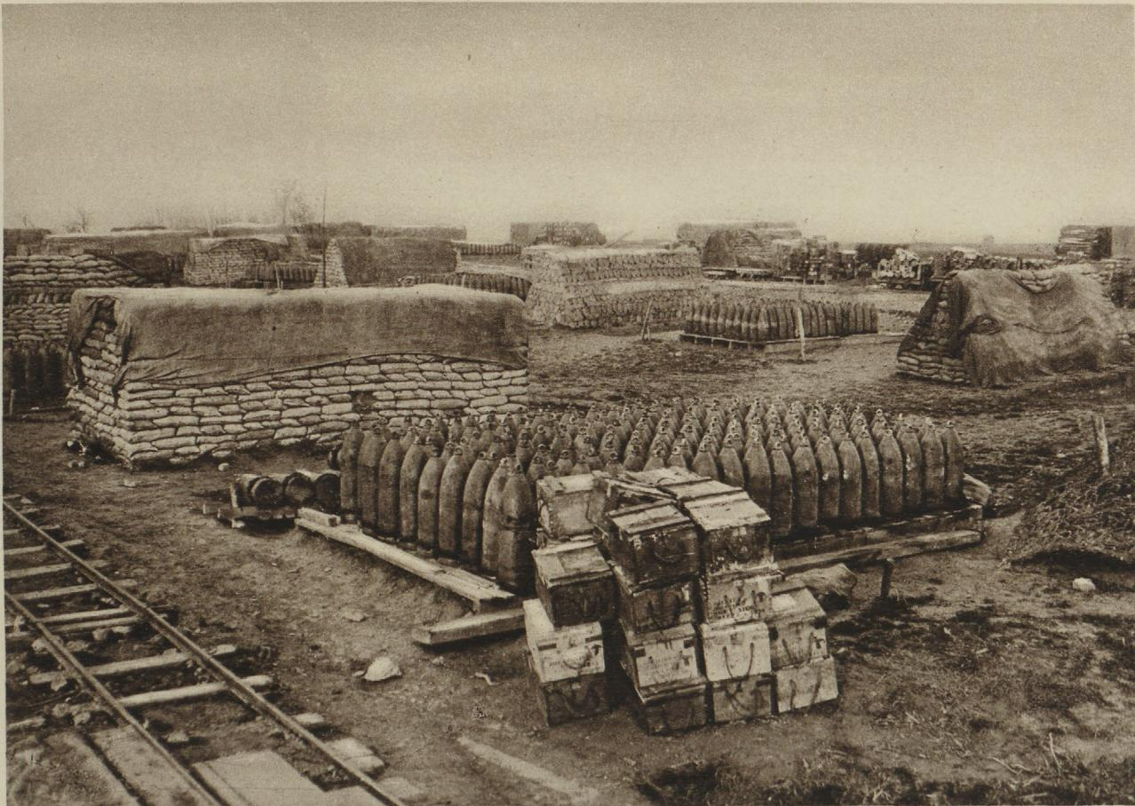
In der „Großen Schlacht in Frankreich“ erbentetes englisches Munitionslager bei Aubigny. Um bei einer Beschießung oder Bombardierung des Lagers Explosionsübertragungen zu vermeiden, wurden die einzelnen Munitionstapel durch Wälle gefüllter Sandsäcke von einander getrennt.
