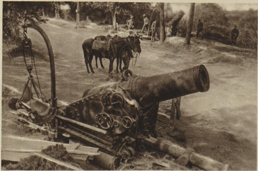
Erbeutete Batterie von 28 cm Mörsern beim Dorf Mareuil. Mit Hilfe des am Fuße des Geschüzes angebrachten Kranes wurden die Geschosse zum Rohreingang geführt.
