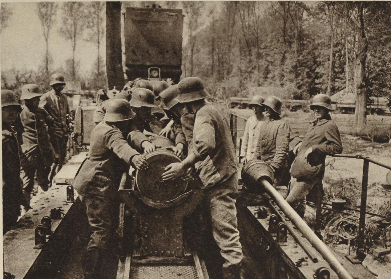
Die 38 cm Granate wird in das Rohr eingeführt. Mit der Verwendung der leichten 38 cm Sprenggranate erzielte man Schußweiten von etwa 47 km. Weit übertrroffen wurde dieses Ergebnis mit der Verwendung des sog. „Krupp'schen Versuchsröhres“ (33,5 cm Kaliber), mit dessen Hilfe 62 km überbrückt werden konnten, sodass von Cambrai aus die feindlichen Hauptquartiere und Eisenbahnknotenpunkte in St. Pol und Doullens unter unser Feuer gerieten
