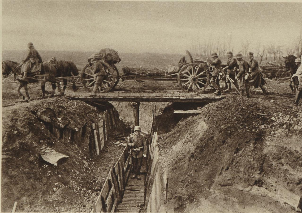
Feldartillerie überquert auf einem von unseren Pionieren in aller Schnelligkeit hergestellten Notsteg die gestürmte feindliche Stellung. Auf der Lafette sind Faschinabündel befestigt, die zur Überwindung von Gräben benutzt werden.
