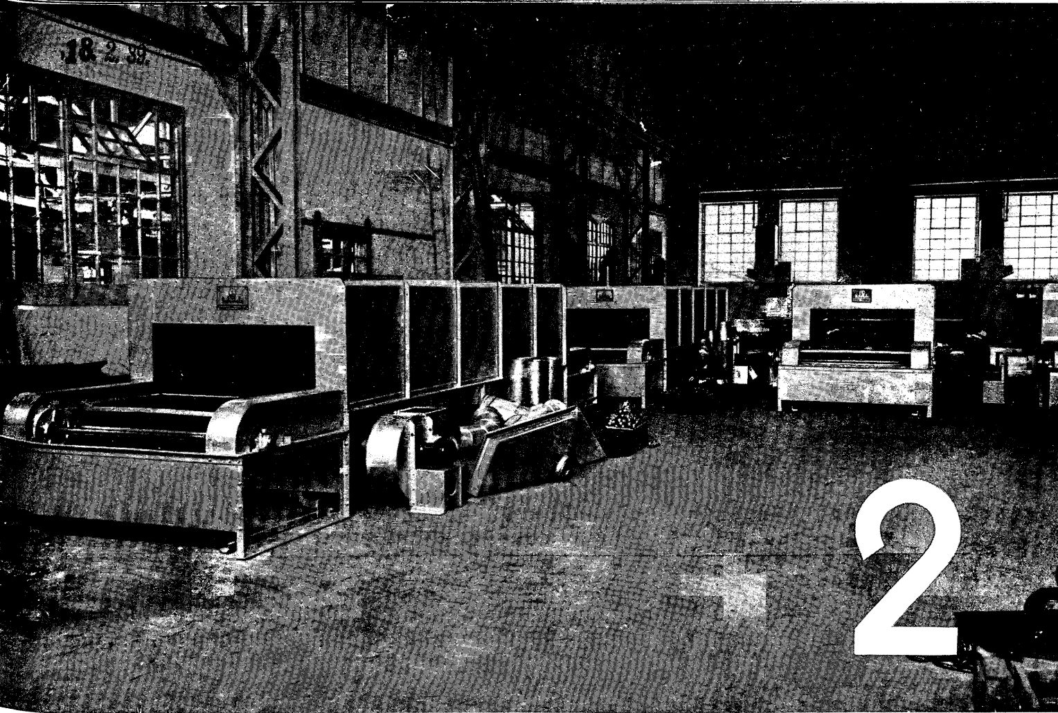
Stätten deutscher Arbeit: Benno Schilde Maschinenbau A.-G., Hersfeld (Bez. Kassel) Aufstellung einer Serie von Schilde-Metall-Waschmaschinen (Teilansicht) für eine ausländische Bahnbehörde während der Montage
