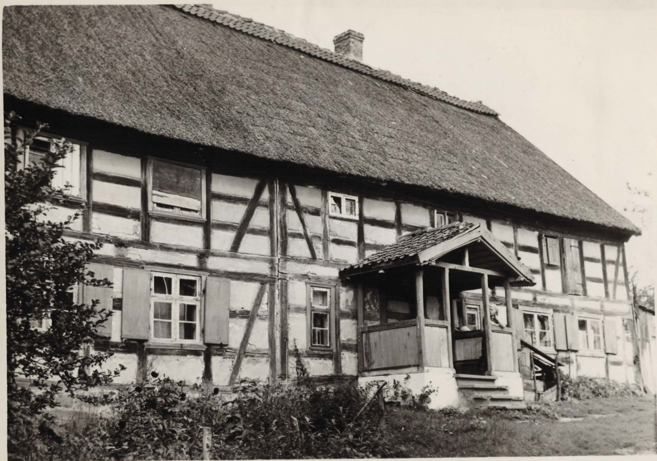
Pilona: Dom mieszkalny Nr. 8 piętrowy, ryglowy remontowany w roku 1936, klasycyzujące drzwi.
