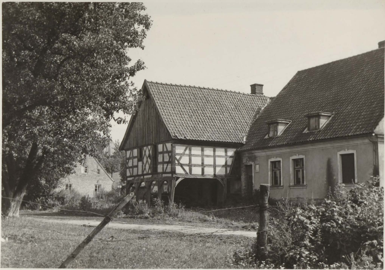
Próchnik: Dom Nr. 35, podcień z I poł. XIX w. Dom St. Wiktorowskiego z końca XVIII w., podcieniowy z charakterystyczną wyżką, stan b. zły.
