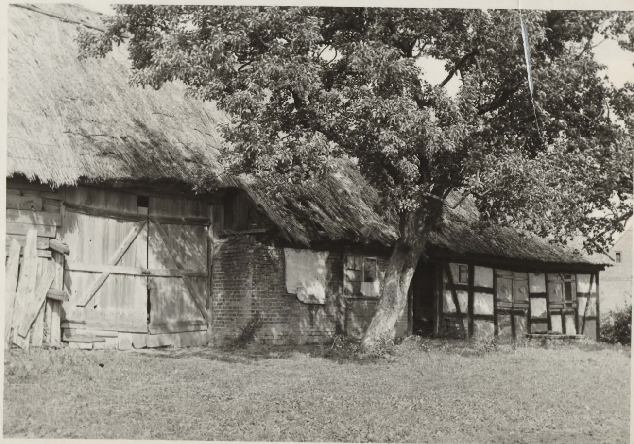
Próchnik: Dom Nr. 56 z I połowy XIX w. ryglowe wypełnienia glinką.
