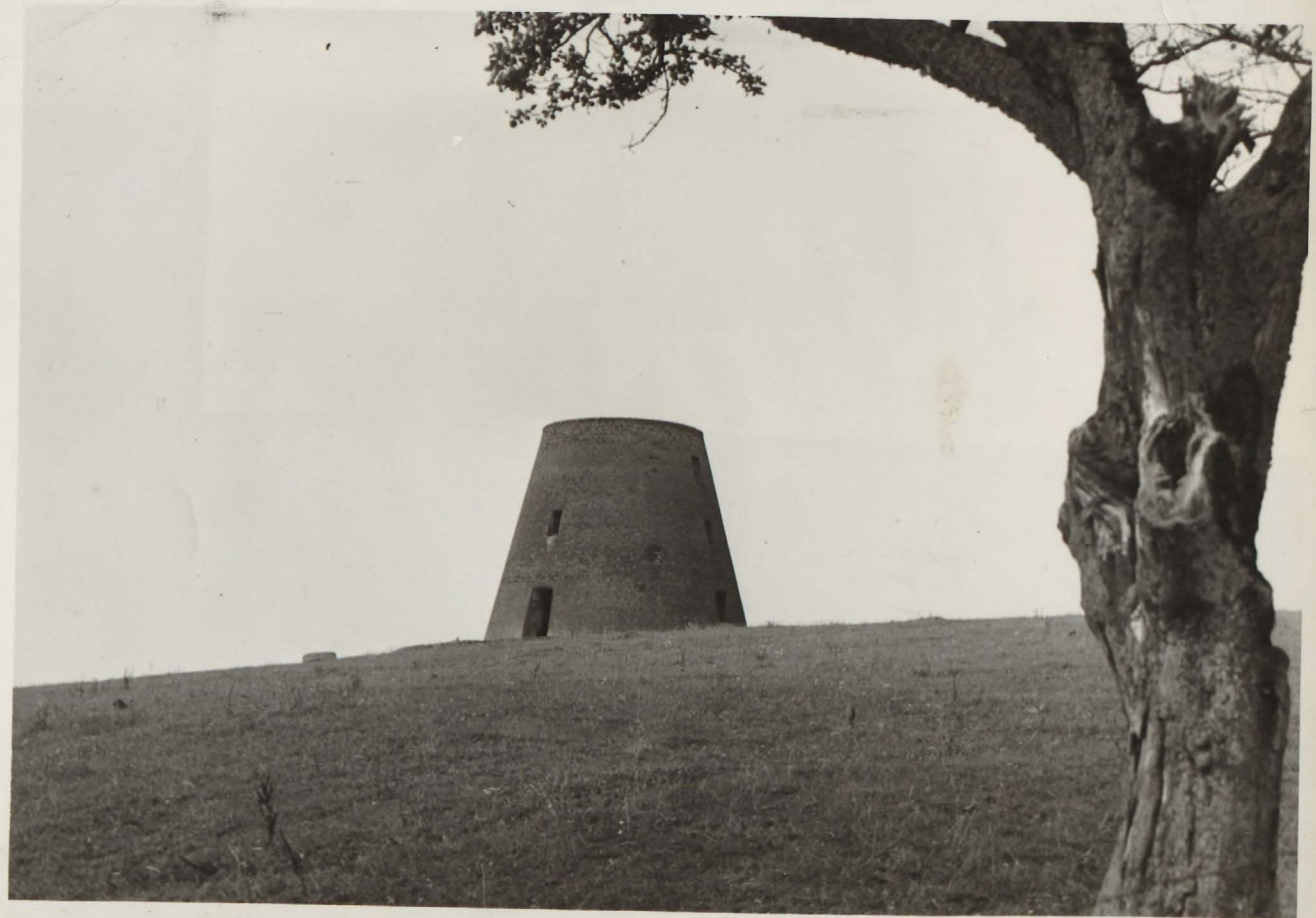
Łęcze: Na północny zachód od wsi wiatrak murowany, wieżowy, obracana głowica urwana, wewnątrz puste.
