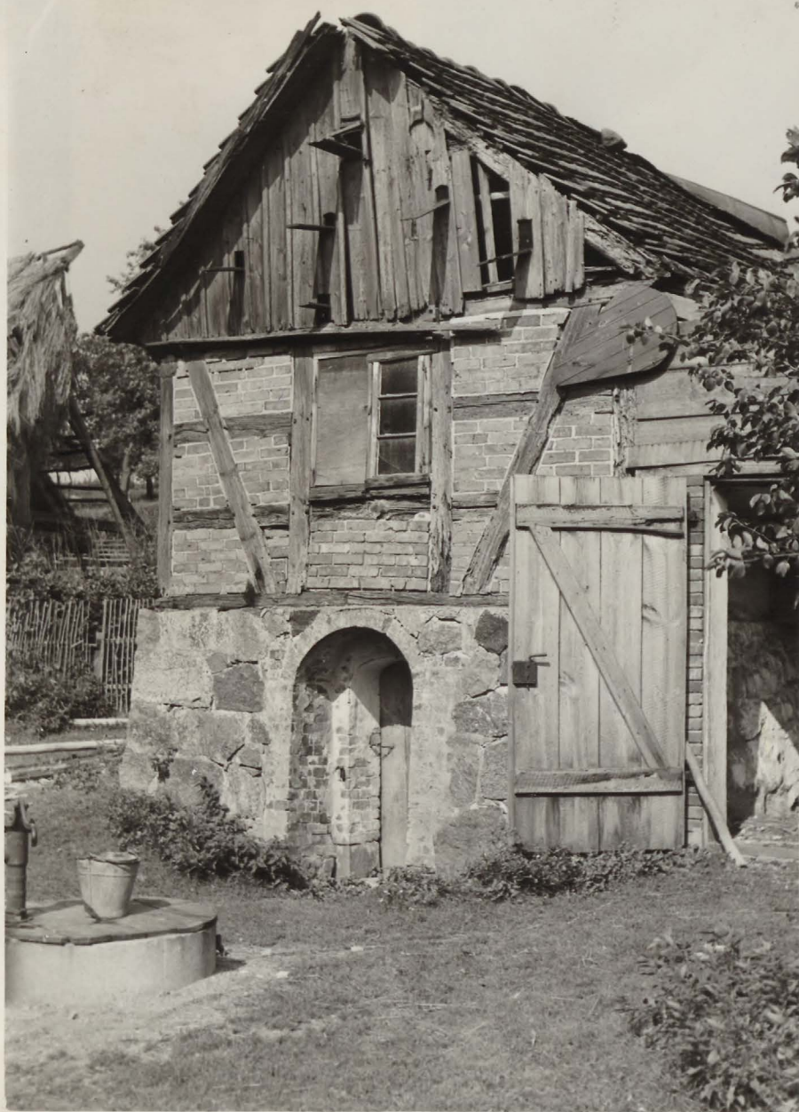
Kęcze: z tyłu domu Nr. 26 piwnica, stare mury. Obok studnia.
