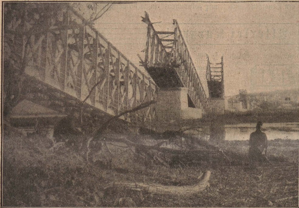
Mittleres Bild: Die berühmte Donau-Eisenbahnbrücke Semlin-Belgrad, die von den Serben bei ihrem Rückzug zerstört wurde. Ueber die unbeschädigten Pfeiler ist eine neue Eisenbahnbrücke gebaut worden. Hierdurch wird die Bahnverbindung Berlin-Konstantinopel in kürzester Zeit wieder dem Betrieb übergeben werden können.
