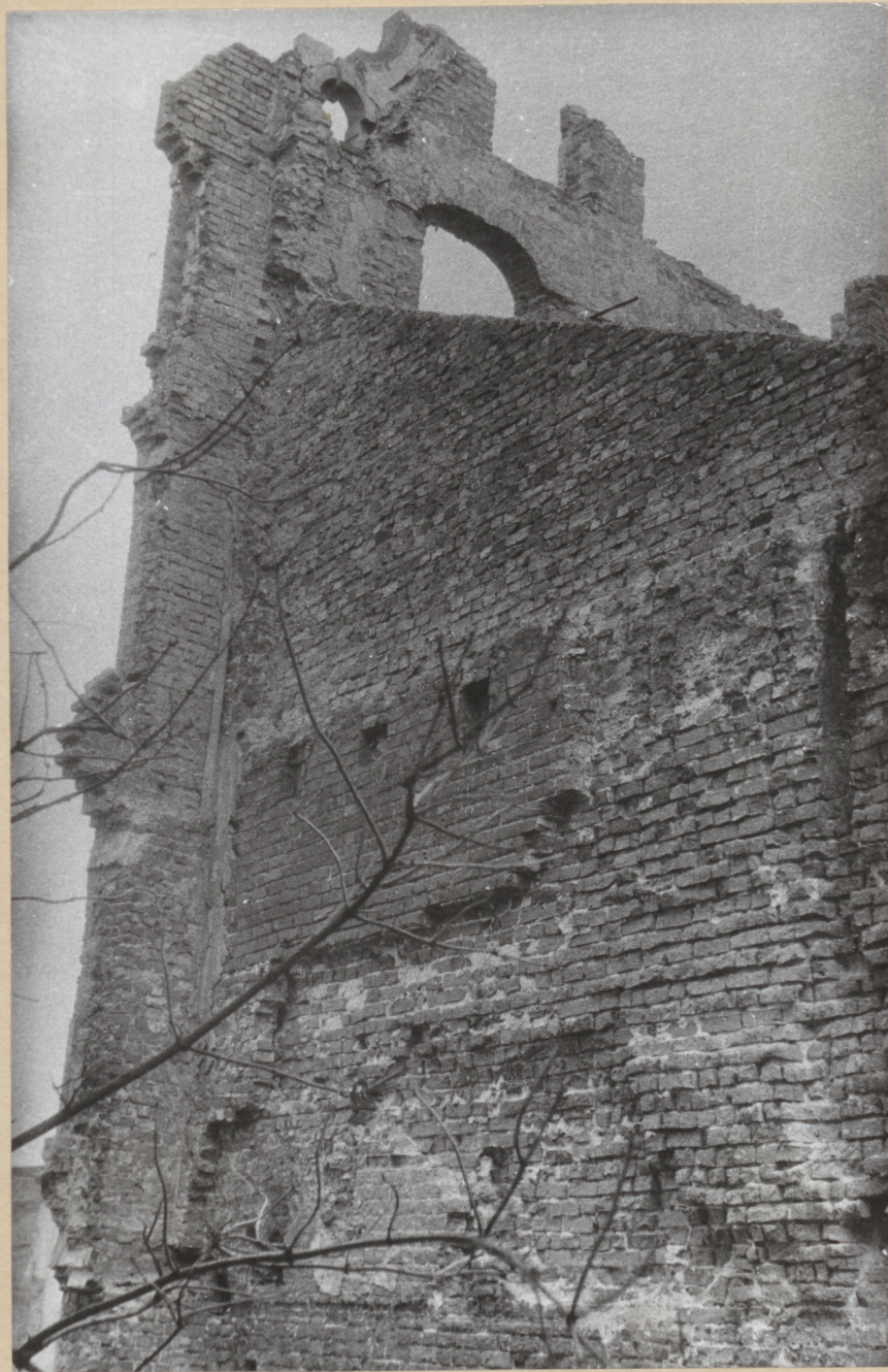
26. Kamieńczyca nr 2. Fragment ściany wschodniej z naroż- nikiem północnym. Górna część.
