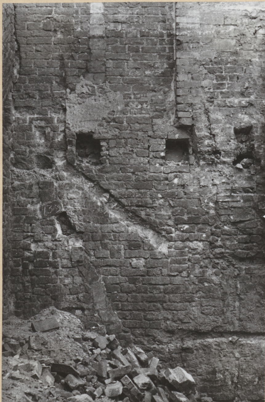
24. Kamieniczka nr 2. Fragment ściany zachodniej przy ścianie południowej. Widoczne późniejsze przeprucia i otwory na belki stropowe.
