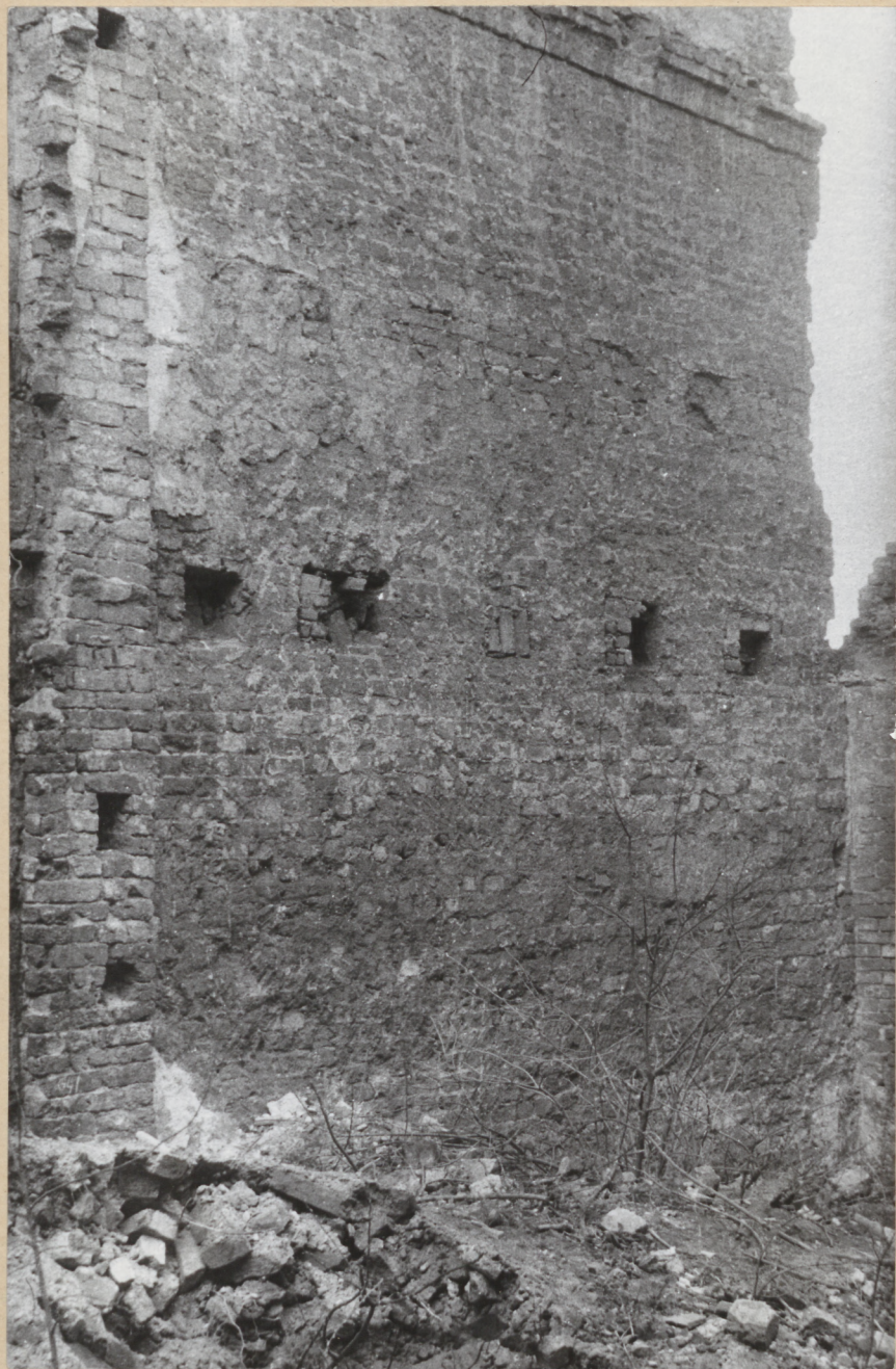
23. Kamieniczka nr 2. Dolny fragment ściany zachodniej.
