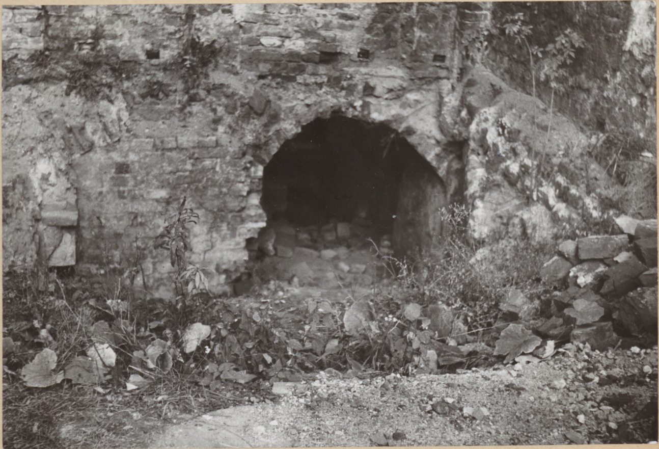
19. Kamieniczka nr 3. Fragment zniszczonych piwnic. wejście do piwnicy przedproża.
