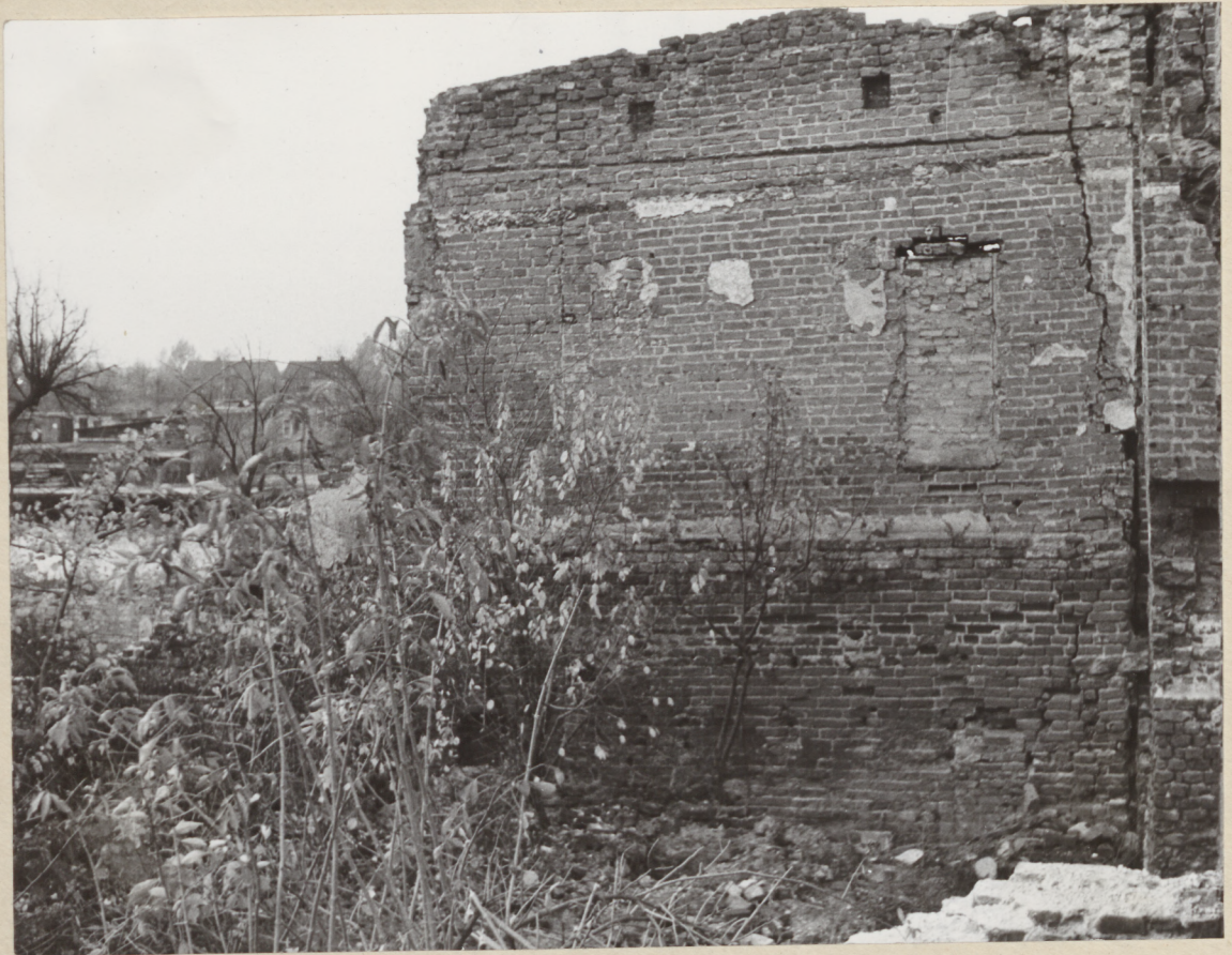
14. Kamieniczka nr 3. Zachodnia ściana gotyckiej przy- budówki od strony podwórza.
