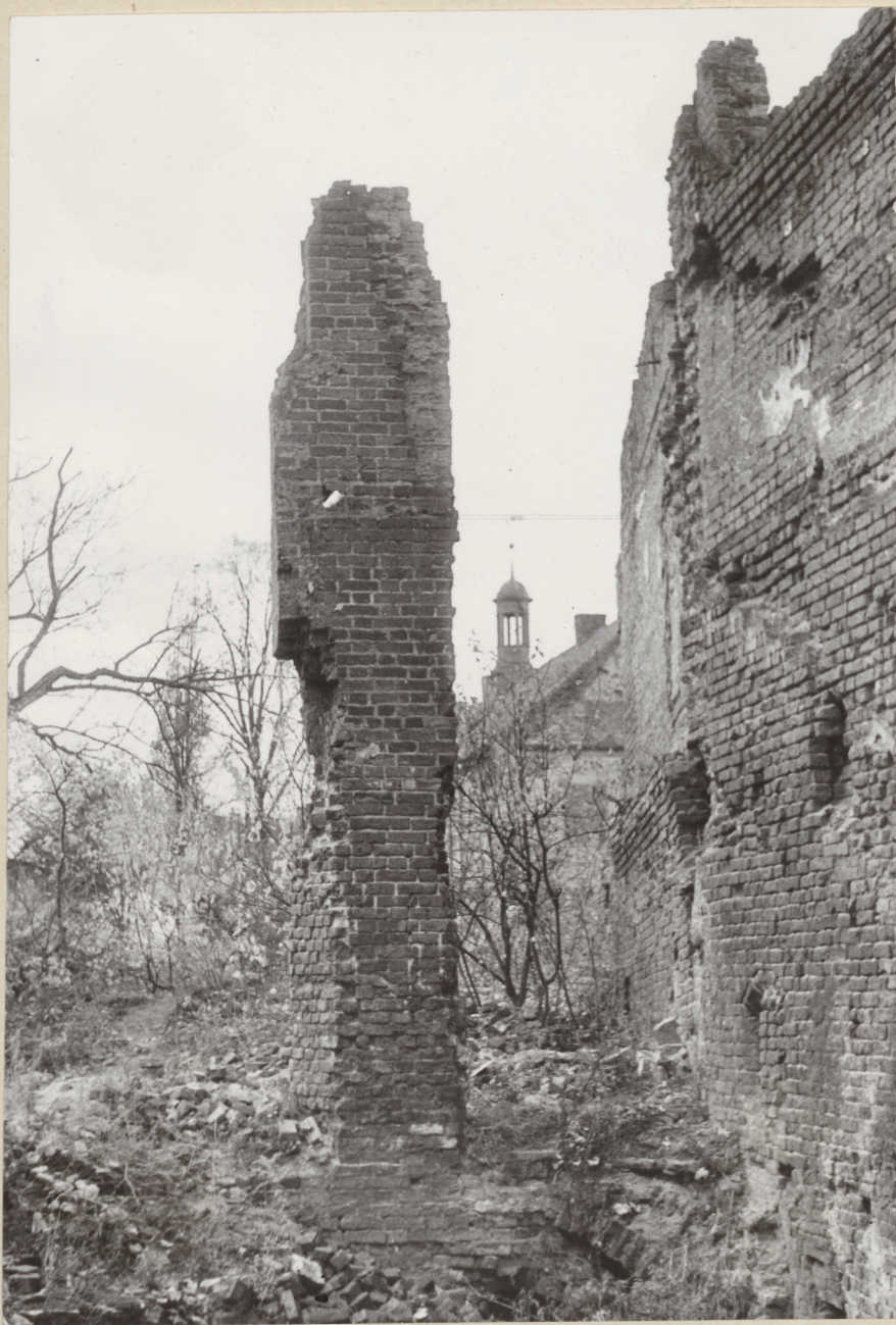
12. Kamieniczka nr 3. Fragment ściany zachodniej przy podwórzu oraz zachowany fragment gotyckiej ściany południowej.
