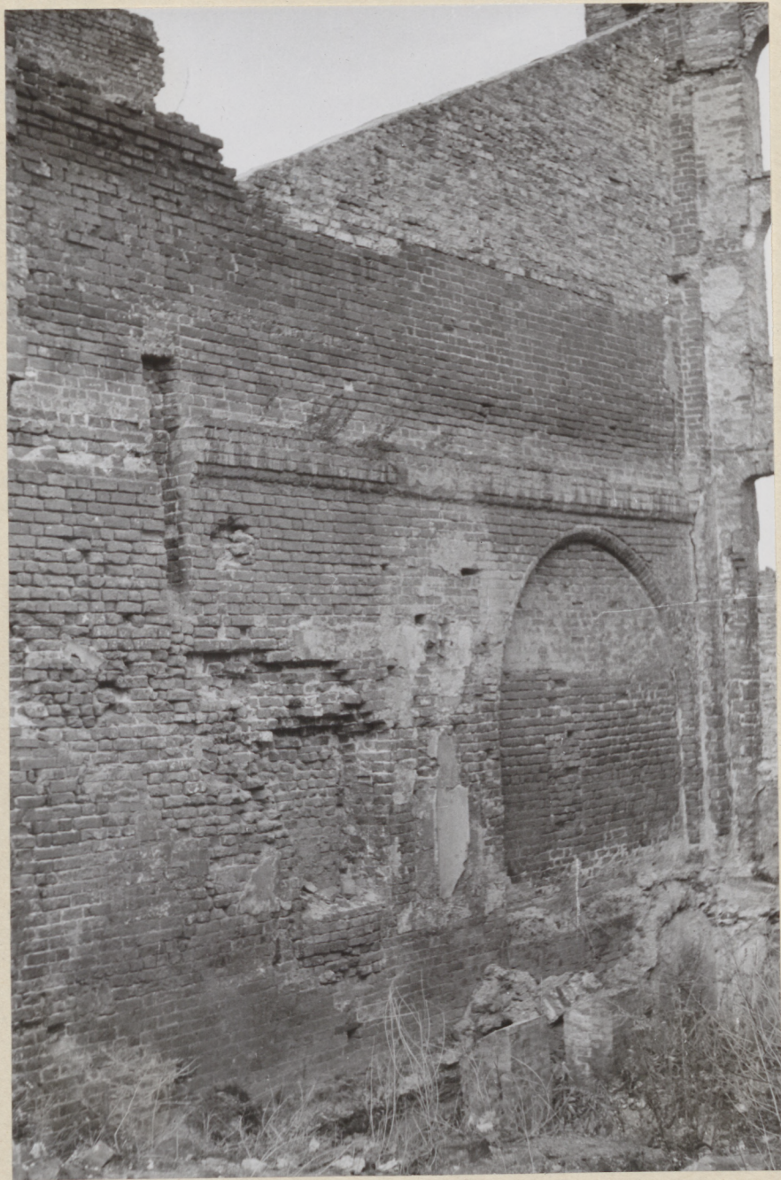
10. Kamieniczka nr 3. Fragment ściany zachodniej. Do połowy II kondygnacji watek gotycki. W przyziemiu pierwotna arkada.
