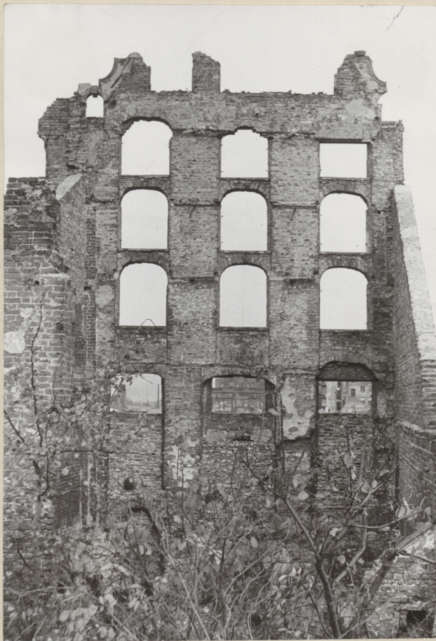
9. Kamieniczka nr 3. Elewacja frontowa. Widok od wnętrza.
