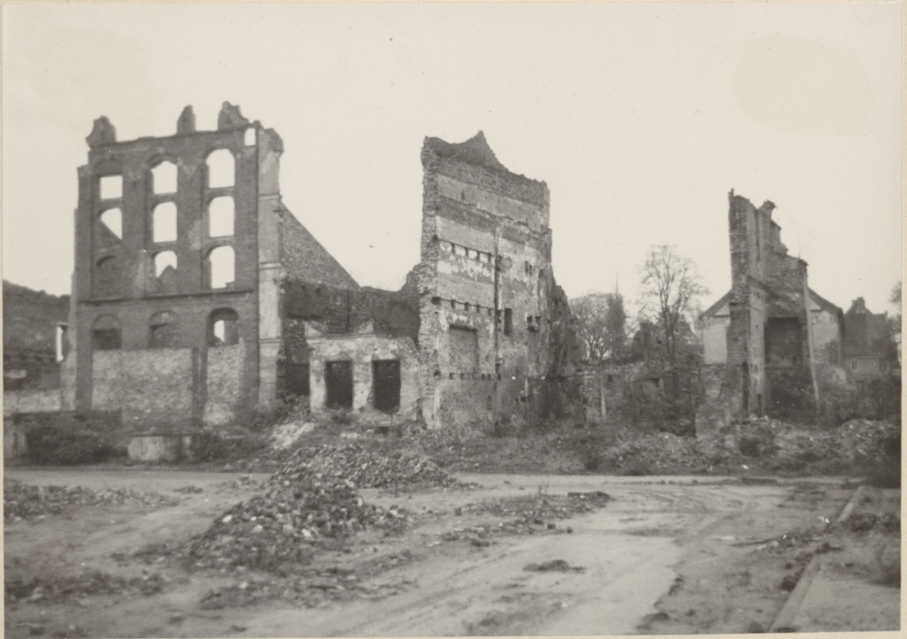
6. Widok ogólny kamieniczek nr 2-3 z kierunku północno-zachodniego. Stan po zabezpieczeniu ocalałych murów.
