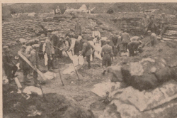
Ausbau eines großen Sprengtrichters.
