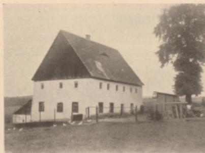
Abb. 2. Umbau eines Arbeiterhauses zu einer kleinen Ruhbauernstelle von 4 ha (neuer Zustand).
