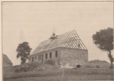
Abb. 2 Umbaustelle einer verfallenen Schäferlei in eine Aufbaubauernstelle
