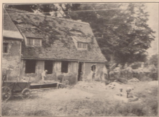
Abb. 3 Der Einbau von Landarbeitertwohnungen in alte Remisen
