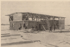
Bild 2 Im Rohbau nahezu fertige 30-Morgenställe
