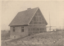
Selbsthilfebau im Lehmfachwerk (Kr. Greifenhagen 1931)
