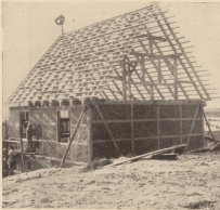
Selbsthilfebau im Lehmfachwerk (Kr. Greifenhagen 1931)
