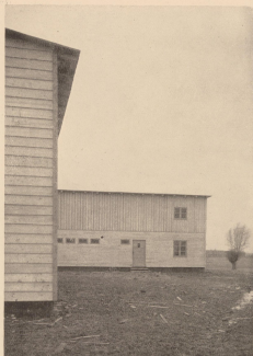
Siedlung Gr. Lauth Kollbauernstelle in Fachwerkbauweise
