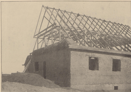
Bild 2 Lehmwellerhaus im Bau
