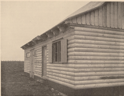
Siedlung St. Lauth, Vorkolonistenstelle in Blockhausbauweise (Joh. Tepper, Angerburg) Teilansicht
