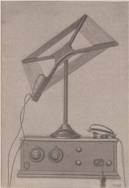
Abb. 6. Die fertige Kipprahmenantenne.
