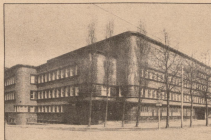
Architekt Professor Alfred Fischer Essen-Foto D. W. F. Siedlungsverband Hauptgebäude, Essen
