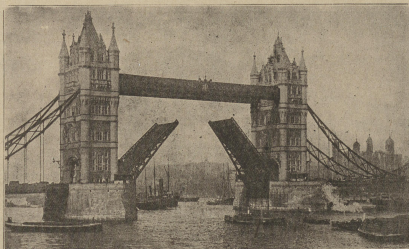
Die Towerbrücke in London, welche durch deutsche Fliegerbomben beschädigt wurde
