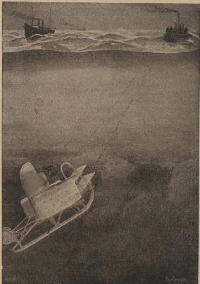
Unterseezylinder in Betrieb.
