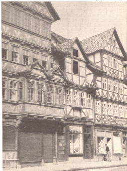
Alte deutsche Fachwerkhäuser in Bad Soden-Neudorf an der Berra
