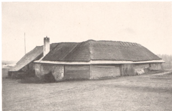
Abb. 4. Blockständerwand der Scheune eines Dreiseithofes im nö. Waldviertel bei Perthenenschlag.
