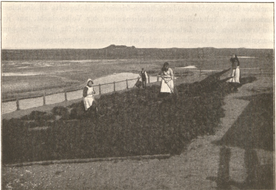
Abb. 2. Ausbreiten auf der Werftböschung.
